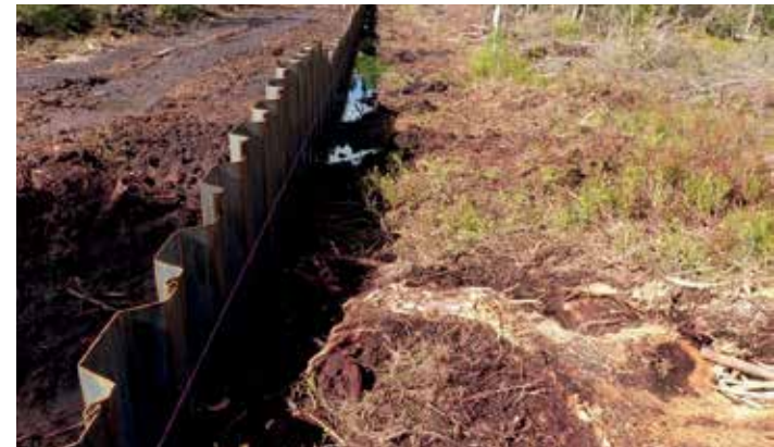
La realizzazione di un canale di drenaggio in una torbiera.
